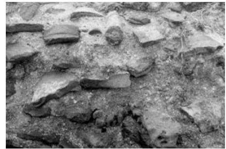
Figura 4 - Calcestruzzo romano con rottami di anfore impiegato per il molo di Cosa
